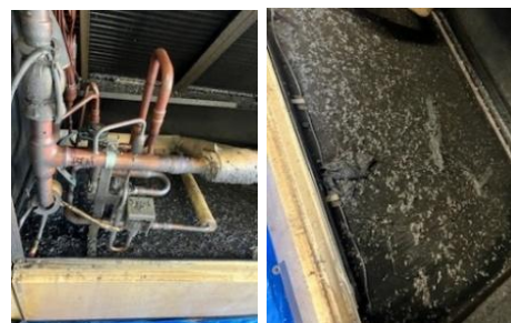
エアコン内部にオイルミストと 金属粉が侵入し、付着
