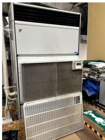
設備用エアコン ベルトレスタイプ (FVYCP224MA) +パウダーガードフィルタ
