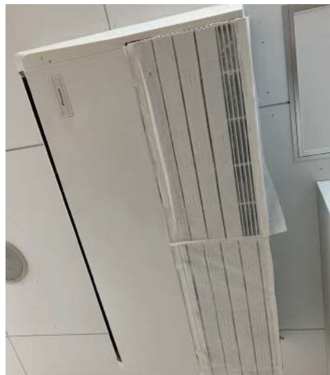
薄いフィルタを設置し対策
