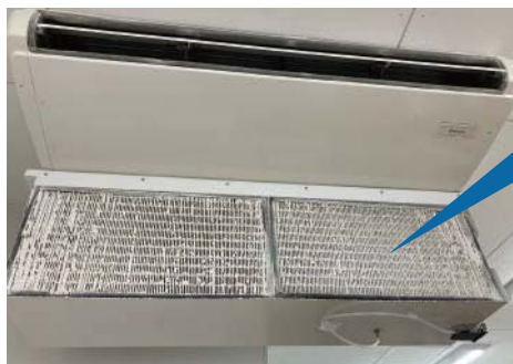
2ヶ月間の使用で、フィルタで多量の粉体を捕集
