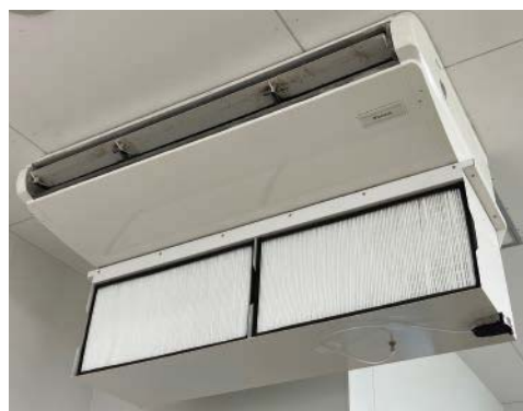
天井吊形エアコン (FHP80DJ) + パウダーガードフィルタ
