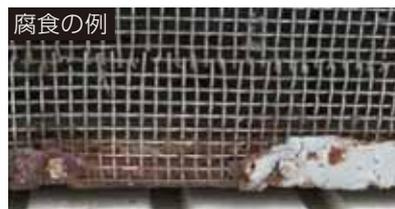
大気中に含まれる海塩粒子が施設内に侵入することでダクトや構造物、電気設備などの金属部が腐食などの被害を受けることです。
