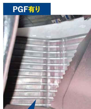
パウダーガードフィルタを4ヶ月間使用粉の侵入を防ぎ、 エアコン内部を綺麗な状態に保つ
